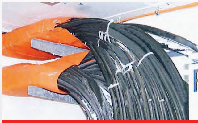
Äußere Umwicklung einer Kabelbahn, aufgelegt auf Konsolen mit Wanddurchführung, Abschottung in der Wand mit HBT Brandschutzmörtel M3
