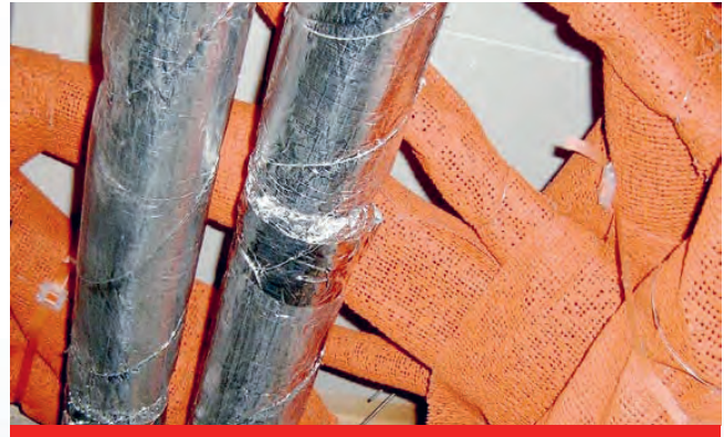
ISITHERM Kabelbandage um Kabeltrassen/Kabelbündel gelegt
