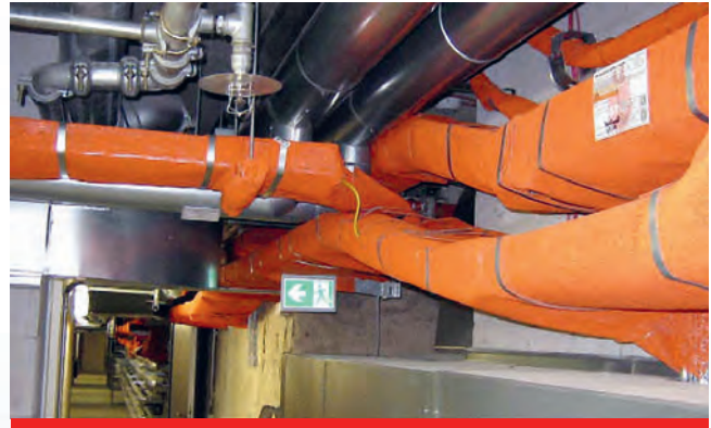
Umhüllte Stahlblech-Kabelträger
