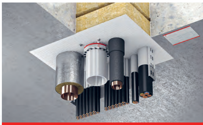
Schott in einer Massivdecke
